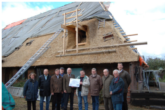
Der symbolische Bewilligungsbescheid wird dem Museumsverein an der „Dachbaustelle“ übergeben. Foto: Giglberger
